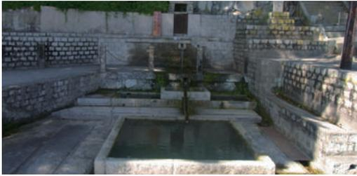
集落の東には唐櫃浜の1号池のほか小さな溜池がいくつか並んでいる。標高150<sup>㍎</sup>付近に湧水帯があるらしい。そのなかの一つ、神社横にある明神池の水源、さぬきの名水にもえらばれている「唐櫃の清水」を見ることができた。石造りのタンクに水温摂氏15度の湧水が吹き出し、吐出し口からの水はかつて飲料水として利用された。その余水は下に設けられた石造の3つの水槽に導かれる。すなわち、直下中央の少し高いところにスイカなど食物を冷やす枡があり、そこから溢れた水が左右の野菜などの洗い場と洗濯物の濯ぎ場に分離する仕組みになっている。さらにその下には障子など大物の洗い場と衣類の洗濯場があり、洗濯場の下手がオムツの洗い場だったという。ここは、1960年代に水道がひかれるまで、集落中の女たちが集まり、一日中井戸端会議で賑わったところ。また、水を汲みに来る子供たちに集落の一員としての自覚をもたせる躰の場でもあった。
