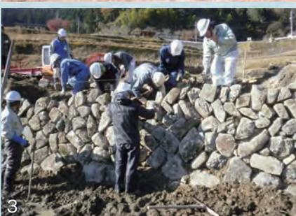
岐阜県恵那市の中野方地区は、棚田と生活と里山が一体となった景観が特徴である。坂折棚田のほぼ中央に赤河断層があり、その影響で直径50センチ〜5センチの自然石がたくさん出土する。整形せずそのまま使った積み上げ、棚田となった。崩壊するたびに田直しを繰り返してきた結果、今日の坂折棚田が誕生した。比較的手頃な石が多く、曲線の石積みもあることから、繊細でやさしい女性的な石積みとなっている。
