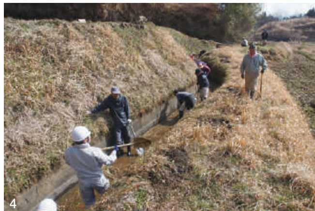
1：山都町棚田の被害の遠景／2・3：熊本地震では棚田にも大きな被害が出た／4：水路泥浚えボランティア
