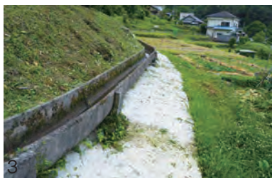
1：取水口／2：山際に築かれた溜池・東ノ池／3：2kmに及ぶ用水路
