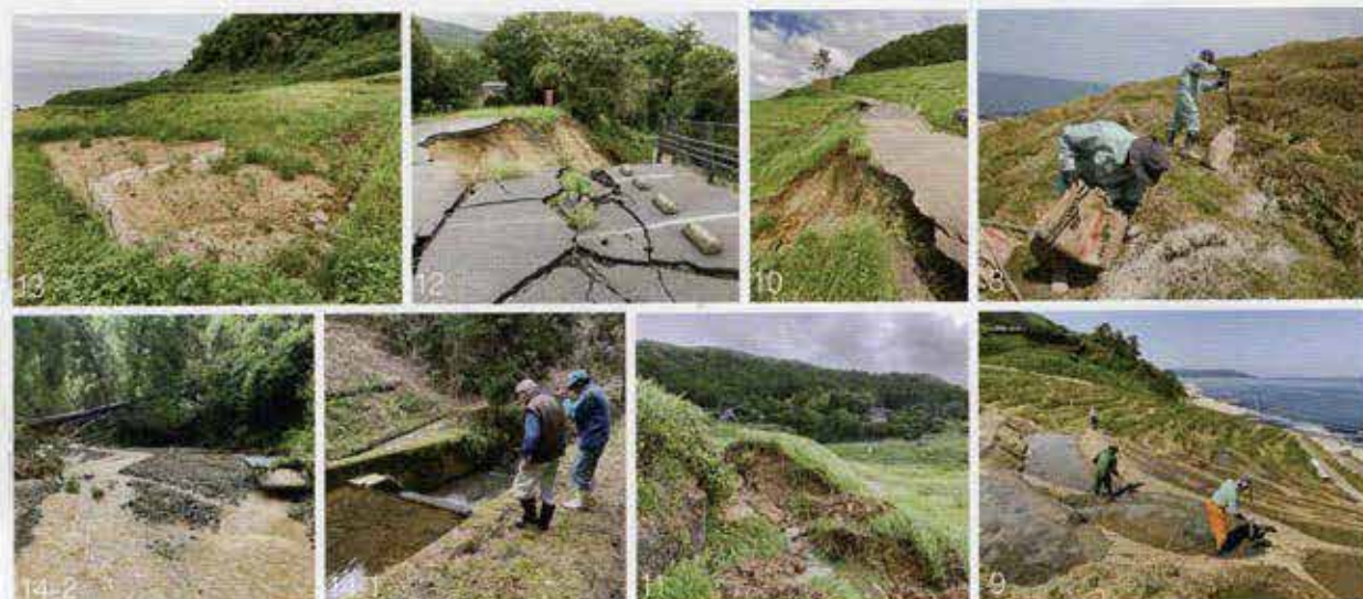
8・9: 復旧作業。田植え準備もした / 10・11: 地滑り / 12: ポケットパーク駐車場の崩落 / 13: 土砂の流入 / 14-1・14-2: 谷山用水が大雨で再び損壊。豪雨前の頭首工(右写真)は豪雨で跡形もなく流され(左写真)、取水口の場所も分からなくなっている
